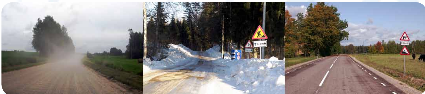
Ceļš pirms rekonstrukcijas
